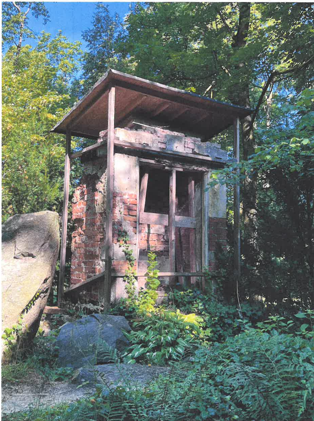
zdjęcie nr 5 elewacja wschodnia po demontażu el. Kamiennych
